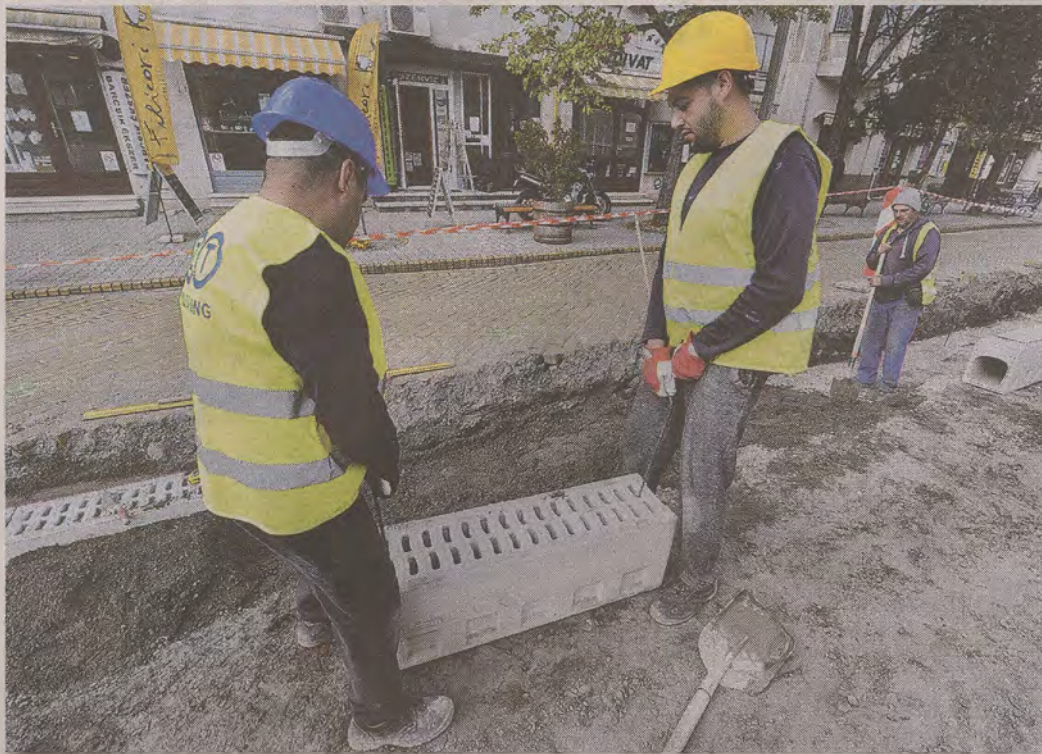
A szakemberek jelenleg a csapadékvíz-elvezető betonelemek építésén dolgoznak A szerző felvétele
